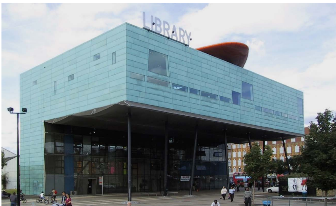
Londra (uk) - Peckham Library & media centre. Veduta esterna (Foto Marco Muscogiuri).
